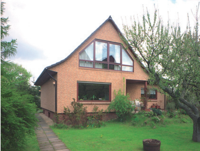
Verklinkerung eines Fertighauses ab Oberkante Sockel
