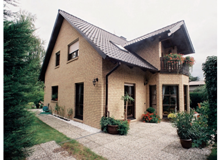
Nachträgliche Verklinkerung eines Fertighauses einschl. Sockel
